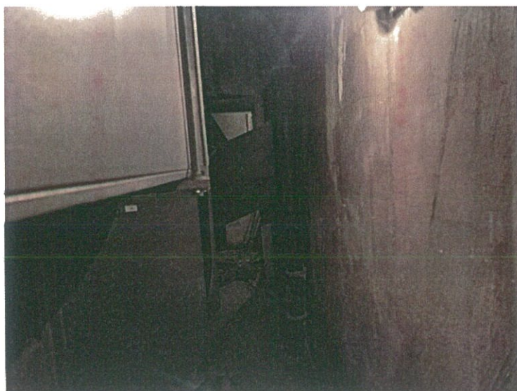
Zdjęcie nr 21 – widoczny pion instalacji kanalizacji sanitarnej w piwnicy. Żeliwny pion z rewizją przeznaczony do wymiany na nowy z tworzyw sztucznych, np. PVC-U lub inny równoważny.
