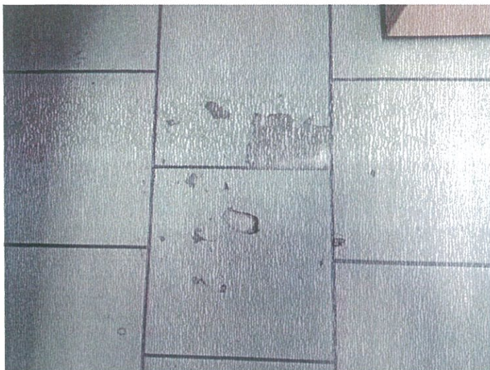
Zdjęcie nr 2 – widok uszkodzonej okładziny podłogowej w pomieszczeniu kierownika magazynu. Zamawiający zaplanował ułożenie nowej okładziny podłogowej z gresu.
