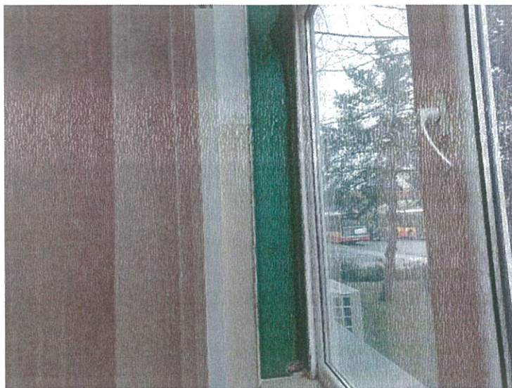
Zdjęcie nr 5 – ościeża okienne do naprawy tynku i malowania w pomieszczeniu kierownika.
