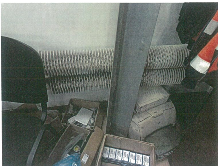
Zdjęcie nr 7 – grzejniki rurowo-żebrowe przeznaczone do malowania w pomieszczeniu biura.
