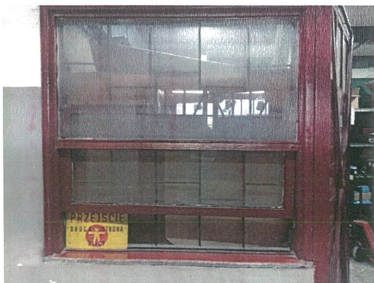
Zdjęcie nr 9 – okno przeznaczone przez Zamawiającego do wykucia i zamurowania w pomieszczeniu magazynu.
