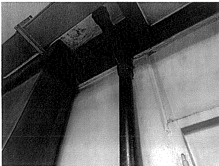
Zdjęcie nr 14 – podstropowa instalacja kanalizacji sanitarnej z żeliwa do wymiany na nową z tworzywa sztucznego w pomieszczeniu magazynu na poziomie parteru.
