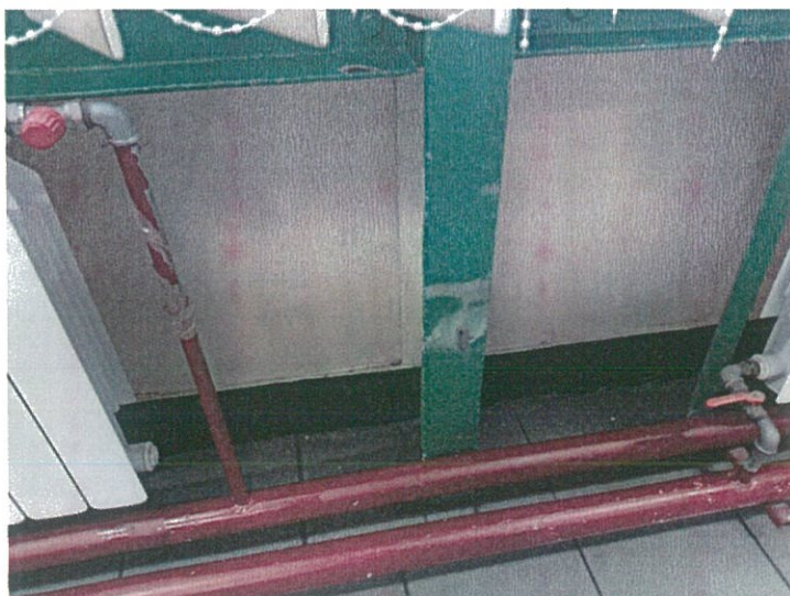
Zdjęcie nr 3 – poziomy i pionowy c.o. oraz konstrukcja stalowa w pomieszczeniu kierownika przeznaczone przez Zamawiającego do malowania.
